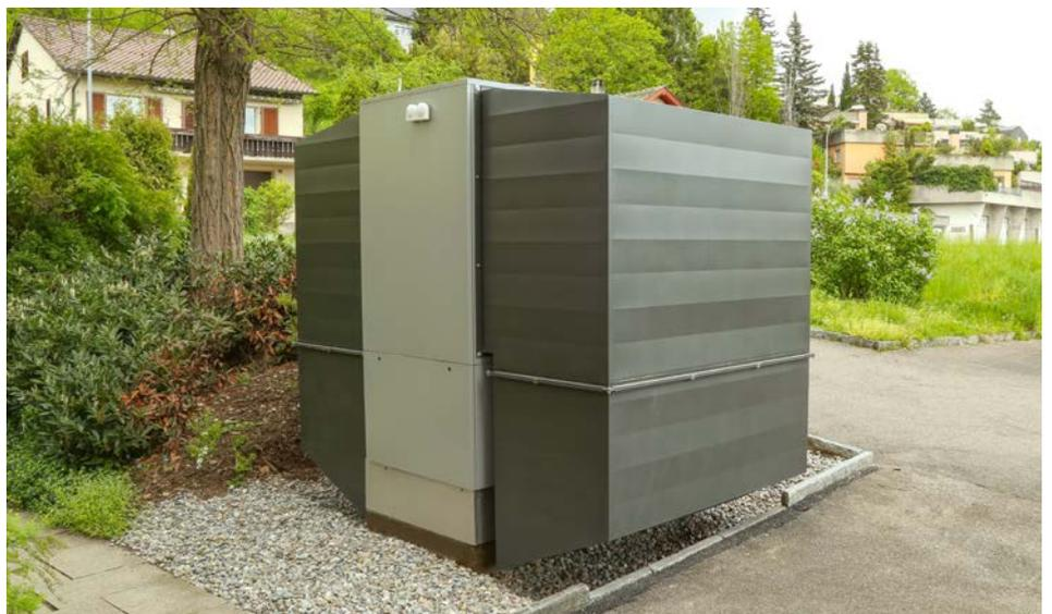
Die Aussenaufgestellte Weishaupt Luft/Wasser-Wärmepumpe WWP LA 60-A R.
