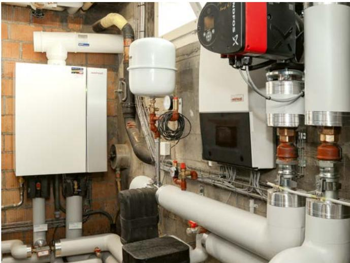
Hinten das Weishaupt WTC-GW 60-B-H Wand-Gasbrennwertgerät mit 60 kW Leistung; links der Wärmepumpenmanager mit farbigem Touchdisplay.
